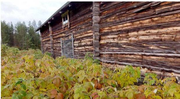
Suvannon rakennettua ympäristöä ulkoa ja sisältä. Kulttuurikerroksen nousun lisäksi rasite rakennuksille ovat seinämällä olevat vatukot ja horsmikot sekä puut, jotka pitävät seinustan märkänä lahottaen rakenteita.
