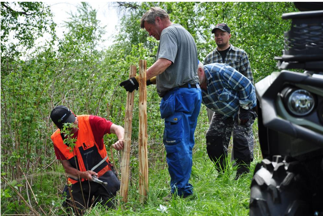
Kuva 13. Viirin kylän lammasaitojen tolppina käytettiin kyllästettyjen tolppien lisäksi itse tehtyjä tolppia. Lampuri Arto Sääskilahti kaatoi, parkkasi ja terotti tolpat ja lahoamisen hidastamiseksi tolppien päät poltettiin.
