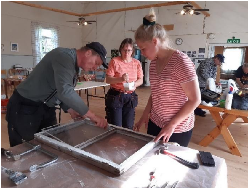
Kuva 16. Sallan Kursun kylällä järjestettiin ikkunapuitteiden kunnostuksen työpaja. Restaurointimestari Seppo Pulska opastaa Lotta Erikssonia vanhan ikkunalin irrotuksessa. Taustalla Kirsi Muuttoranta tekee kittiä, jota tarvitaan mm. lasin kiinnitykseen.
