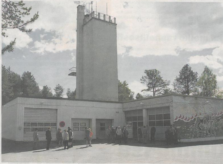
Kulttuurikävelyn aikana tutustuttiin myös vanha paloasemaan. Rakennus on päätetty purkaa, vaikka siitä ei ole tehty
