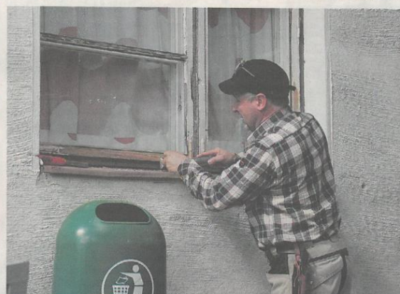
Päivän päätteeksi nähtiin vanhojen ikkunanpuitteiden näytösuuntoinen kunnostustyöpari restaurointimestari Marko Korkeasalon vetämänä. Hän totesi, että esimerkiksi Kitisenrannan koulun ikkunat ovat vielä täysin kunnostettavissa.
