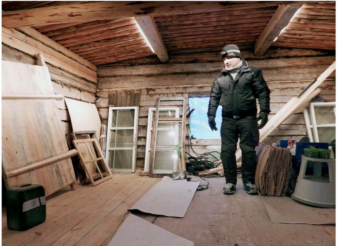
UUSI lattia ja kunnostettu katto on tehty käsityönä. Marko Korkeasalo sanoo, että työ opettaa tekemään.
