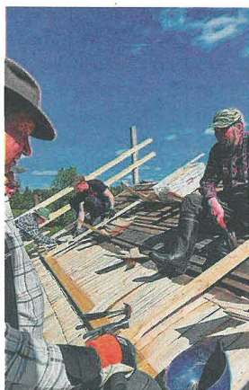
Markku Kujala ja Esa Heinola ovat rakentaneet aiemminkin pärekattoja. Restauraantimestari Marko Korkeasalo uudet työtavat otettiin mielellään vastaan.
