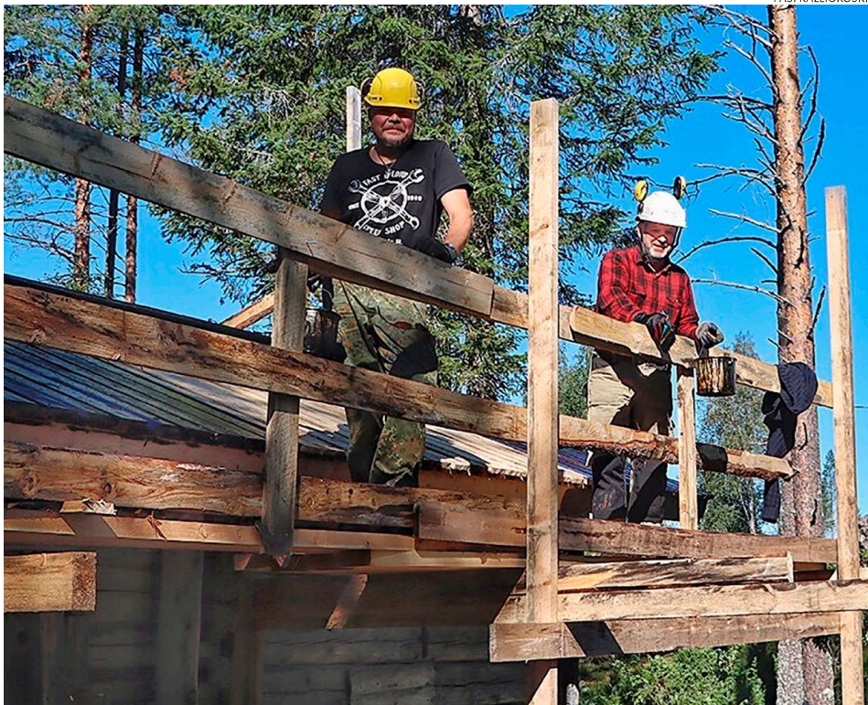
Korjattu lautakatto tiervattiin vielä huolellisesti ennen työpajan päättymistä, jotta se kestää mahdollisimman pitkään. Katolla oleva museomestari Marko Korkeasalo (oik) kuitenkin muistuttaa, että tervauksesta on jatkossa huolehdittava säännöllisesti. Toinen tervareista on OSAO:n restaurointiopiskelija Ari Jellänen.
