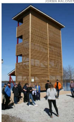
Meltosjärven lintutornin avajaisia vietettiin toukokuussa.
