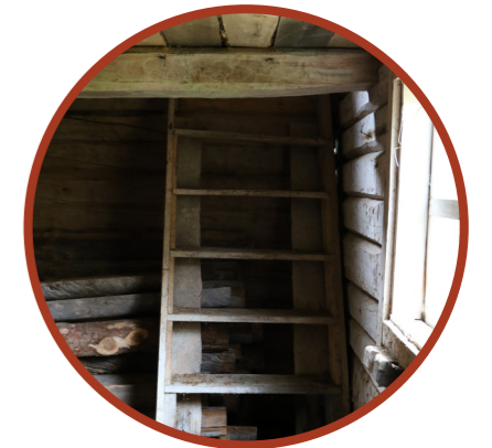
Soppanan myllyn kerrosten välinen sisäporras
