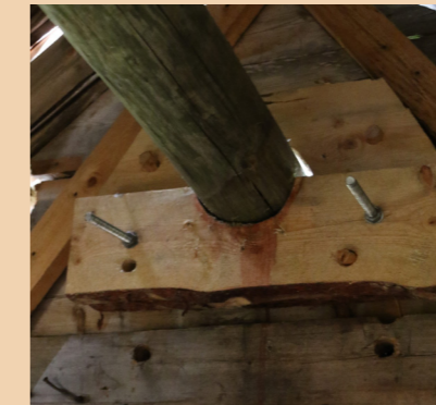
Saraniemen tuulimyllyn osia kiinnitetty suurikokoisilla ruuveilla.
