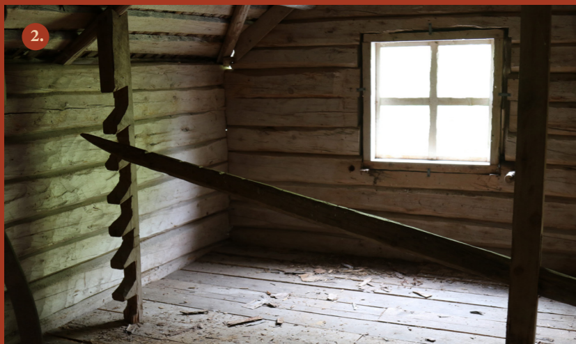
1. Soppanan myllyn vesilunkka, 2. Soppanan myllyn vesilunkan sulkutukin säätö, 3. Kuittarin myllyn vesilunkka, 4. Kuittarin myllyn sulkutukin säätö
