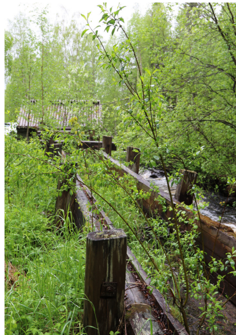
Tuomiojan myllyn rännirakenne.
