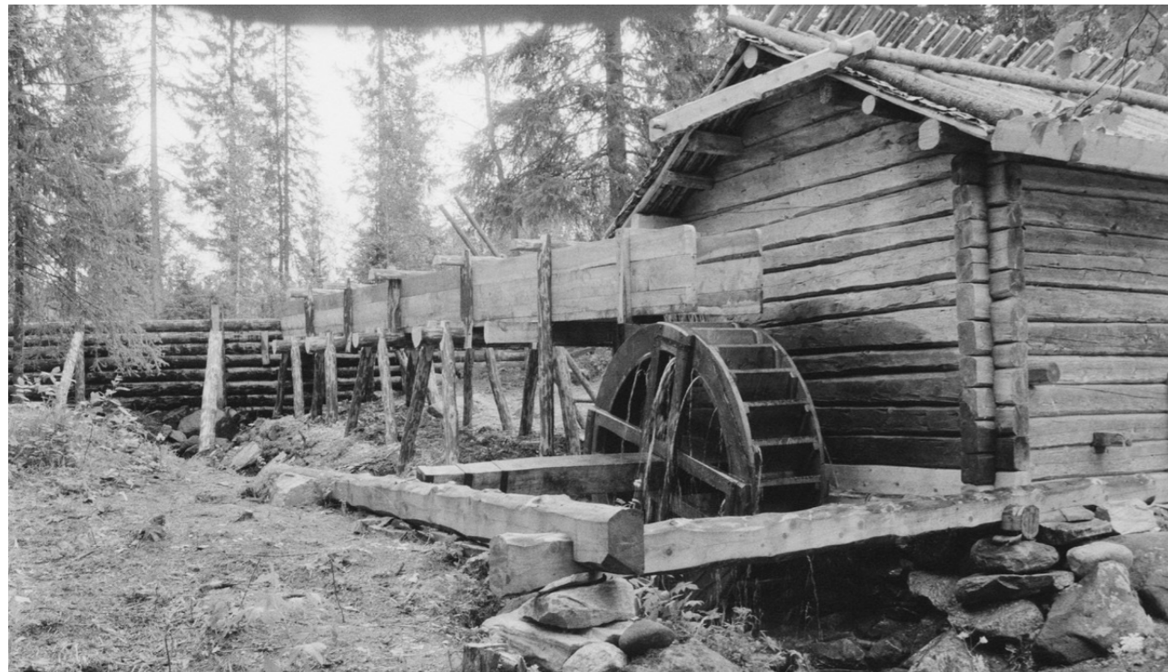
Korkealehdon vesimylly ja ylävedellä käyvä ulkopuolinen vesiratas. Kuva: Veijo Laine, 1990.
