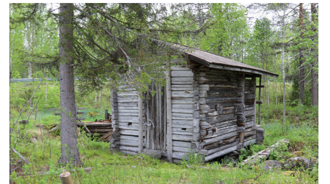
Ranualla sijaitsevassa Kuittarin ratasmyllyssä ei ole ulkopuolista kävelysiltaa tai porrasta.
