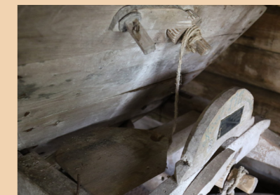
Soppanan myllyn tuutin säätöluukku ja säätöluukun säätömekanismi.
