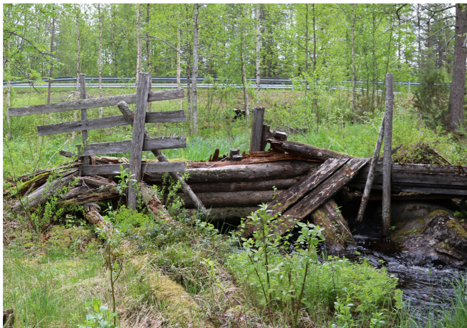
Kuittarin myllyn jäljellä olevia patorakenteita.
