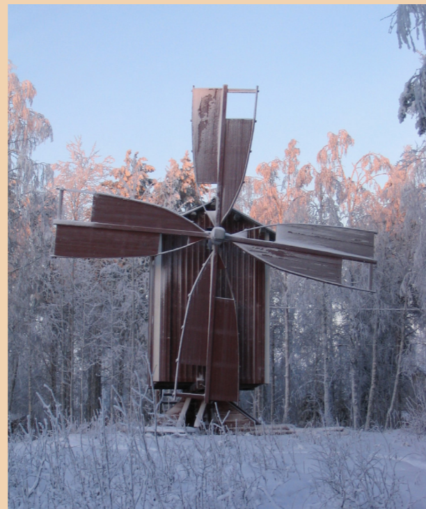
Varastohallissa lepävät siivet paikoillaan Erkkilän tuulimyllyssä vuonna 2004. Kuva: Janne Ukkola, 2004.
