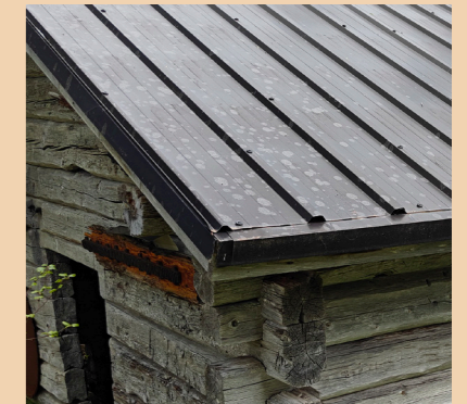
Kylmäniemen ratasmyllyyn on laitettu moderni peltikatto.
