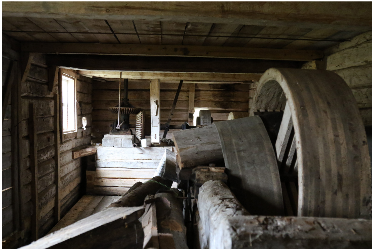
Soppanan myllyn alakerros välityslaitteineen.
