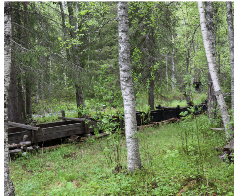
Ulkujoen myllyn rännirakenne.
