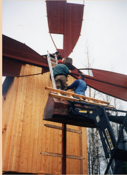
Myllä vuonna 1996: kunnostuksessa mylllyyn tehtiin uudet siivet, se verhoiltiin rimalautoituksella ja mylllyn katto, siipitukka ja varpaat korjattiin. Kuva: Katri Erkkilä, 1996.
