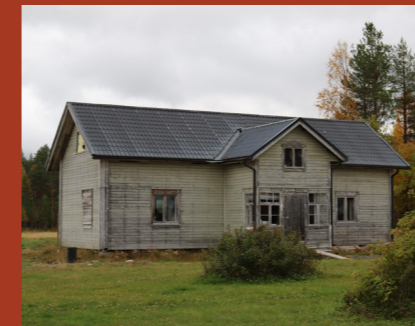
Koskelan tilan kylmillään oleva päärakennus.
