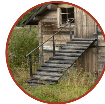
Tuomijoen myllyn kulkusilta, jota pitkin jyvät on kuljetettu ylemmän kerrokseen jauhatusta varten
