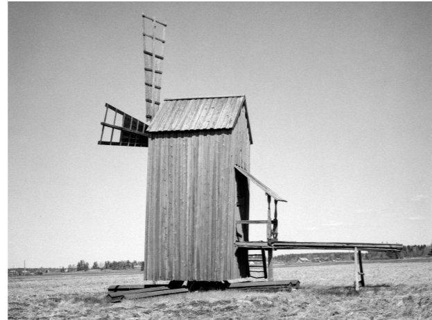
Pyrstöpuulla käännettävä nelisiipinen jalkamylly. Siivissä näkyy avonaisia tuuliluukkuja. Kuva: Auvo Hirsijärvi, 1977.
