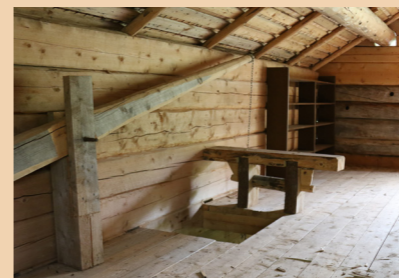
Tuomijoen myllyn mahdollinen jyvien nostolaite myllyn toisessa kerroksessa.
