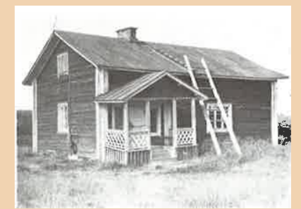
6. 1900-luvun alussa rakennettu uiton pirtti Nivankylässä, Rovaniemellä.
