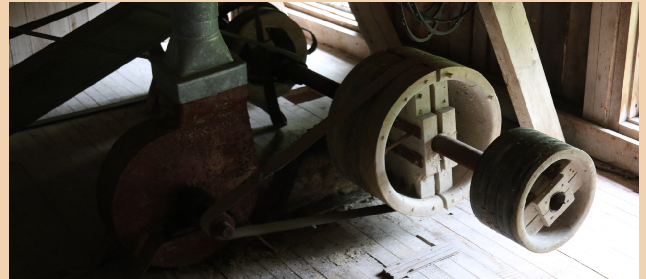
Kolmannen kerroksen pieniä remmipyöriä.
