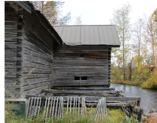
Soppanan (vas.) ja Tuomijoen (oik.) ratasmyllyjen rännirakenteet ovat samankaltaisia ja molemmissa on sihti eli välppä estämässä roskien joutumista vesirattaaseen.
