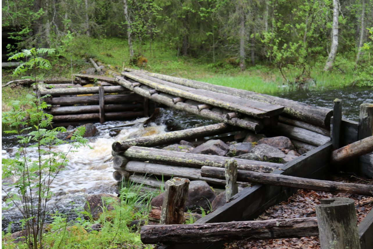
Ulkujoen myllyn tammi on ankkuroitu paikoilleen molemmin puolin jokea olevilla kolmiseinäisillä hirsiarakuilla. Hirsiarakut kannattelevat joen yli menevää kapeaa kulkusiltaa. Tammessa on lähes joen levyinen aukko, jota on luultavasti padottu neuloilla. Neulojen olemassaolosta ei ole kuitenkaan tietoa.
