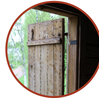
Uulan myllyn yläkerroksen ovi sisäpuolelta
