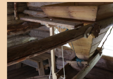
Kuittarin myllyn porsaan kannatusvitsasten sekä säätöluukun säätömekanismi.
