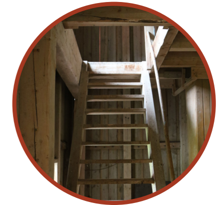
Pöyliön myllyn keskimmäisen ja ylimmän kerroksen välinen porras
