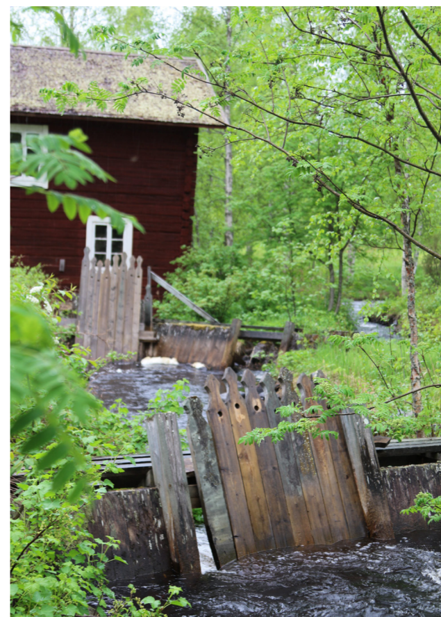
Uulan myllyn omat sivu-uomassa sijaitsevat neulapadot. Takana oikealla näkyy suljettava tulvakanava.
