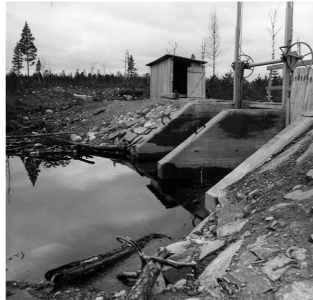
1920-luvulla yleistynyt betoninen patorakenne: oikeanpuoleinen patoaukko padottu neuloilla ja vasemmanpuoleinen setillä. Kuva: Elias Purhonen, 1950
