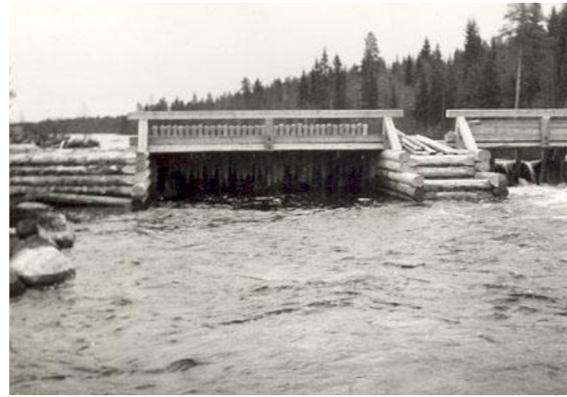
Kalliojärven perinteinen neulapato hirsiarkkuineen: Neulan yläpähän saatettiin veistää kaula, jotta siihen oli helpompi tarttua ja näin vetää tarvittaessa pois uomasta. Neulojen alapää tukeutui puolestaan vesistön pohjassa lepäävään kynnyshirteen. Kuva: Lusto, 1954
