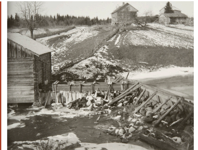
Härkinmyllylle tyypillinen rännirakennelma. Kuva: Esko Aaltonen, 1928–1930
