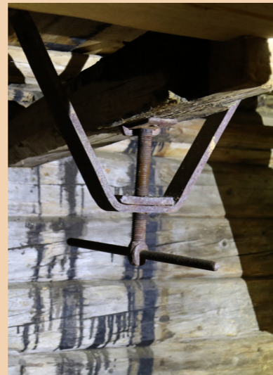
Erkkilän tuulimyllyn ylempään jauhinkiven säätöruuvi myllyrakennuksen ensimmäisessä kerroksessa.
