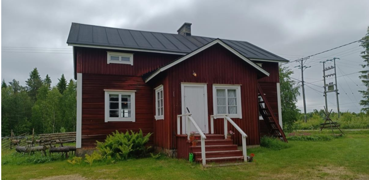
Kuva 5. Puistolan päärakennus. Roosa Kukkonen / Oulun yliopisto
